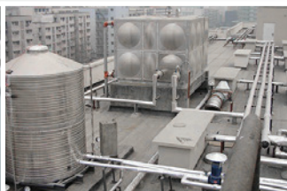
Výroba nádrže na vodu
