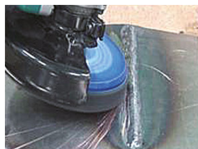
*odstraňovanie farebných defektov po zvaroch
